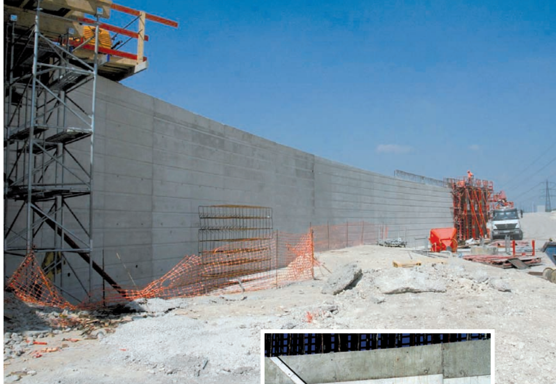
Voile CO s'étirant sur 47 m de long.
