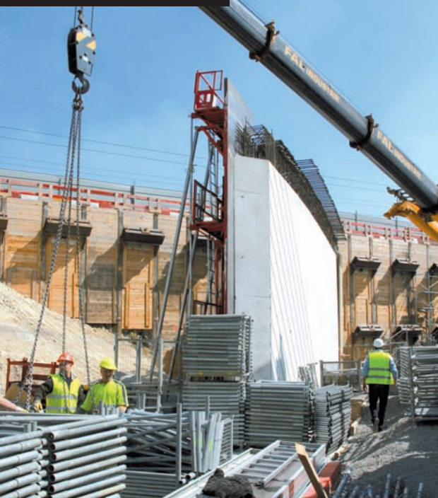
Voile matricée de l'ouvrage OA3 sud.
