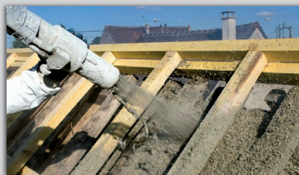
Projection de Béton de chanvre Tradical en application Isolation de Toiture.
